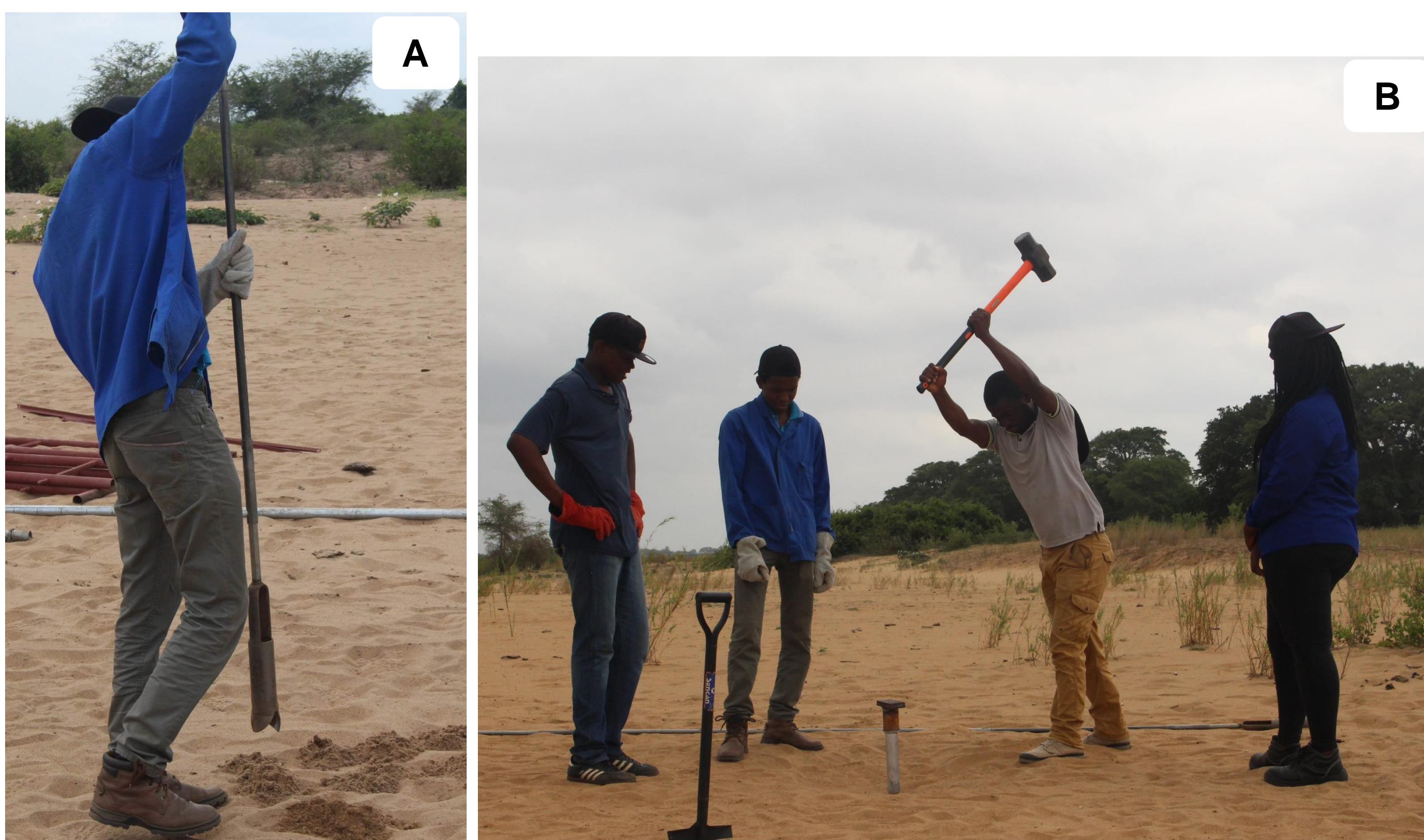
A–Sondagem com trado manual para a caracterização das camadas litológicas B–Instalação de piezômetro para a determinação do nível do lençol freático C–Sondagem geoelectrica com ABEM
